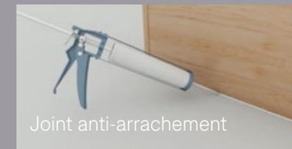
Lors de l'installation de nos produits nous appliquons un mastic epoxy afin de limiter les infiltrations d'eau et minimiser les risques de ligature.
