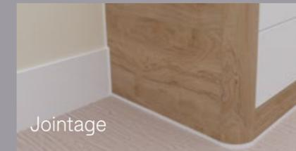
Lorsque le mobilier est fixé au mur, nous prévoyons des espaces pour les plinthes et les canalisations, afin de minimiser les possibilités de dissimulation.
